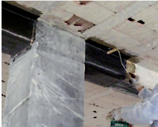
Figura 16 Rinforzo delle travi: puntelli di sostegno posizionati durante le prime fasi di asciugatura della resina (a sinistra).
