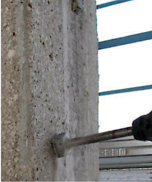
Figura 9 Rinforzo dei pilastri: preparazione della superficie di supporto dei pilastri tramite bocciardatura (a sinistra).
